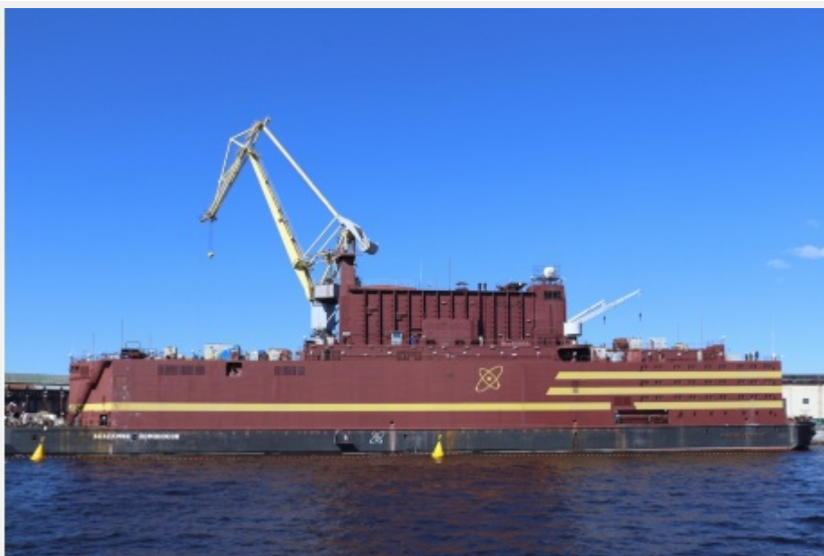
Akademik Lomonosov je ruská plovoucí jaderná elektrárna
